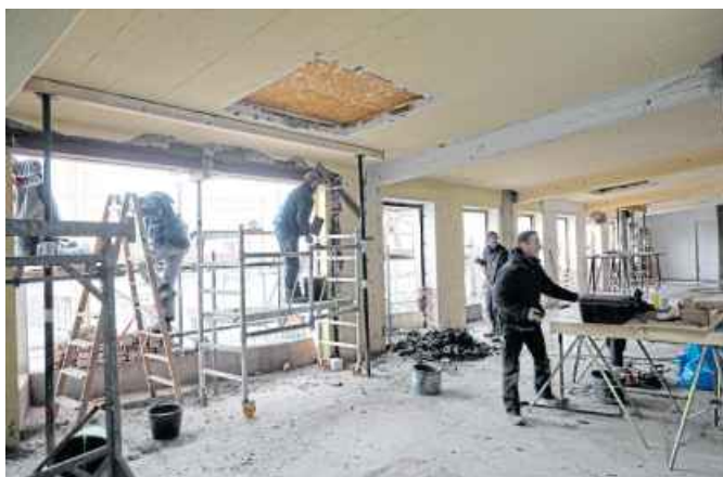
Die Leute von Trias schaffen hier einen Durchbruch für einen Erker mit großem Fenster.
