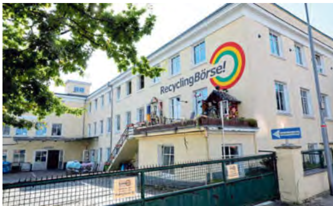
Der Stammsitz der Recyclingbörse an der Heidestraße wird für zwei Bonitas Pflege-Wohngemeinschaften umgebaut.
