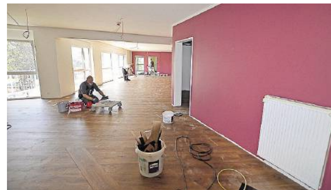
Der Gemeinschaftsbereich von Haus Lummerland ist fast fertiggestellt. Kräftige Farben dominieren in allen WGs die Wände. Der Boden in Holzoptik schafft wohnliche Behaglichkeit.
