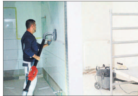
Die Zimmer, in denen derzeit noch fleißig gewerkelt wird, sind zwischen 18 und 29 Quadratmeter groß.
